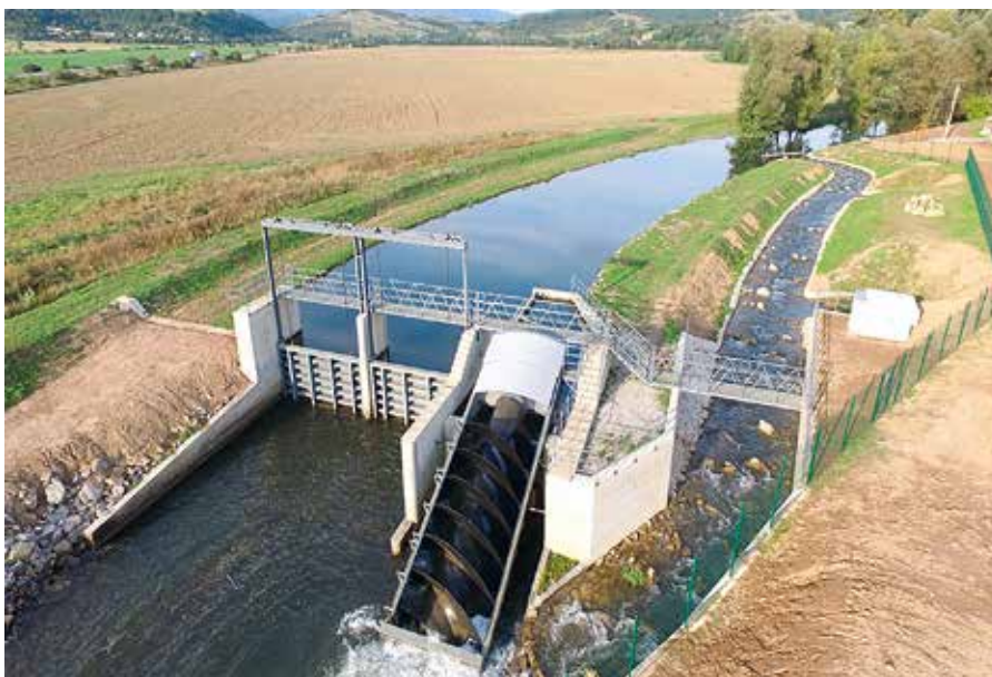
Obrázok č. 3: MVE Čoltovo s Archimedovou turbínou
