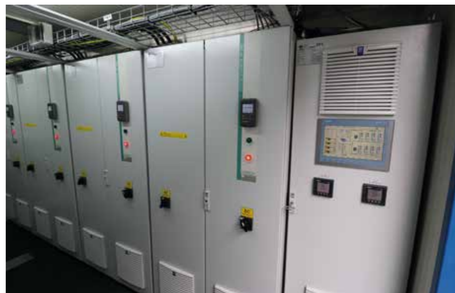
▼ Obr. 5: Fotovoltaické striedače namontované v kontajneri, pripravené na export k zákazníkovi.
