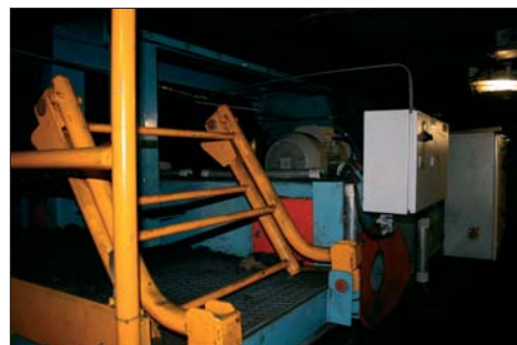
Obr. 2 Rekonstruované vyhrnovací vozíky – Elektrárna Mělník
