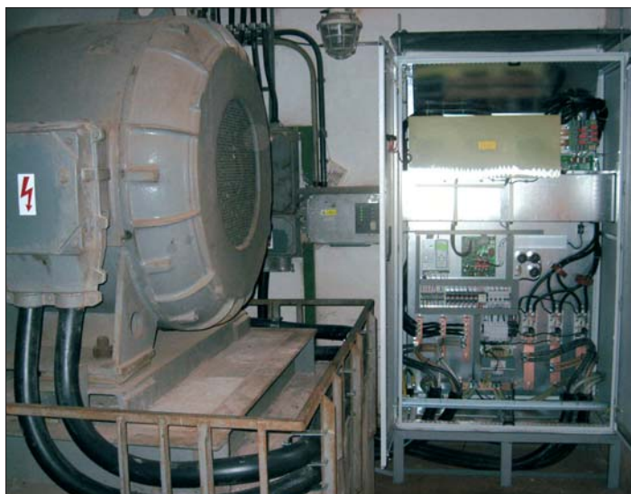
Obr. 1 Pohled do „útrobu“ měniče frekvence VQFREM 400 kW
