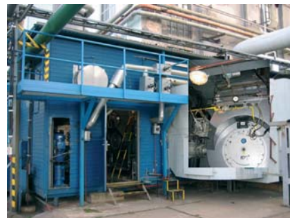
Rekonštruovaný plynový kotol s využitím FM + RS VONSCH
