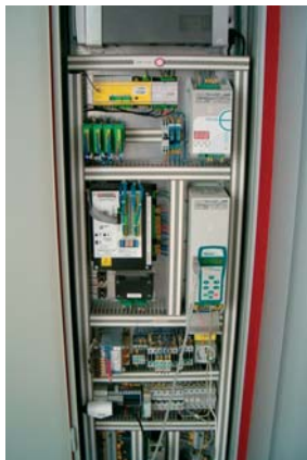
Obr.3 VQFREM 230 E – regulácia otvárania dverí (hore), VQFREM 400 – regulácia posuvu kabíny (dole)
