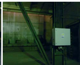
Kompletný rozvádzač s meničmi a výstavou pre posuv EBT brány
